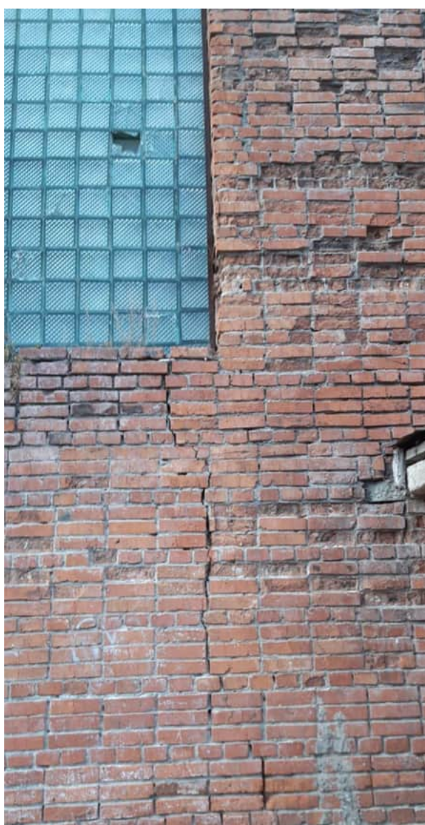
Фото 1.7 Вертикальная трещина в кирпичной стене длиной до 2 м и шириной раскрытия более 5мм
