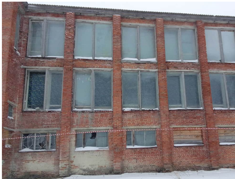
Фото 1.22 Разрушение витражного проема из стеклоблоков
