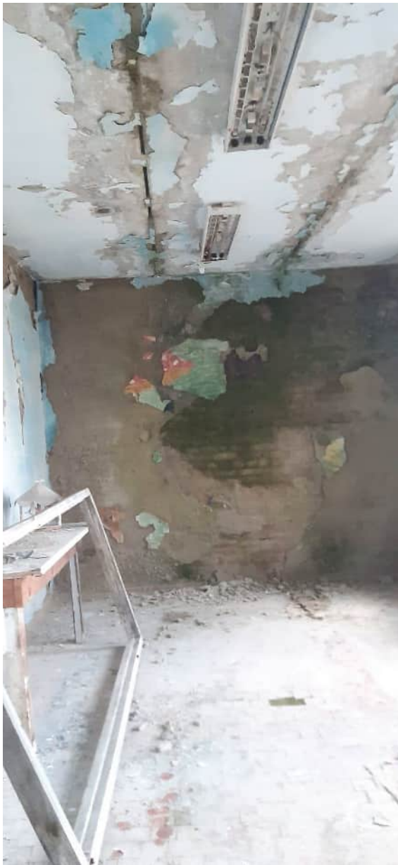
Фото 1.12 Замачивание стен, разрушение штукатурного слоя, образование грибков и плесени на поверхности
