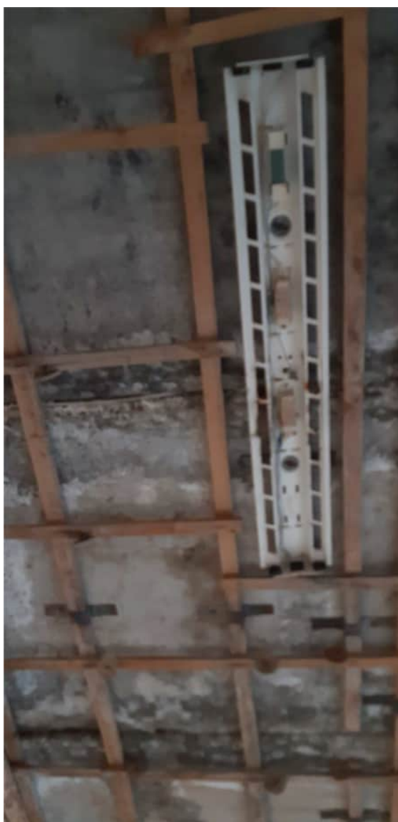
Фото 1.14, 1.15 Замачивание плит, высолы, разрушение штукатурного и покрасочного слоя
